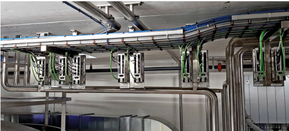
Turcks BL ident-RFID-System verhindert Fehlkupplungen und gewährleistet damit eine konstante Produktqualität
