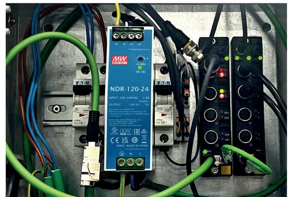
Die Steuerlogik ARGEE auf den TBEN-Blockmodulen übersetzt ERP-Daten in Leuchtsignale für die PTL110 – ohne externe SPS
